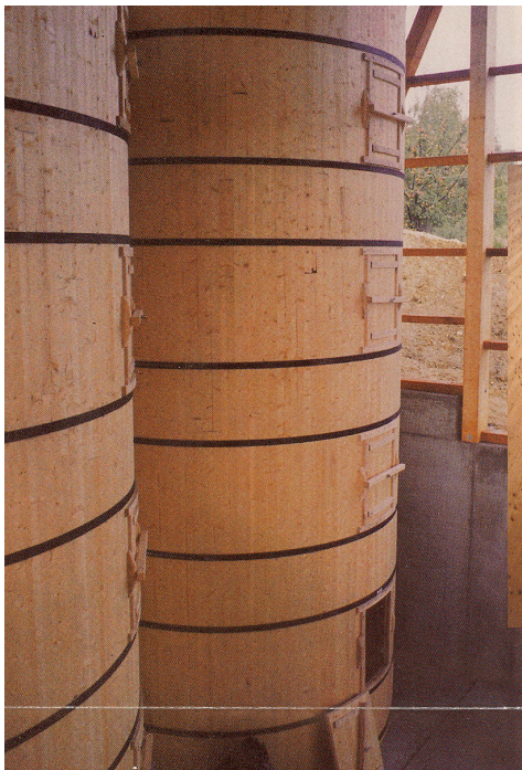
Silo mit einzelnen Auswurfluken
