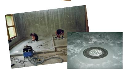
Eine Möglichkeit, den Betonboden zu schützen: Polyesterbelag mit Chromstahlring.
